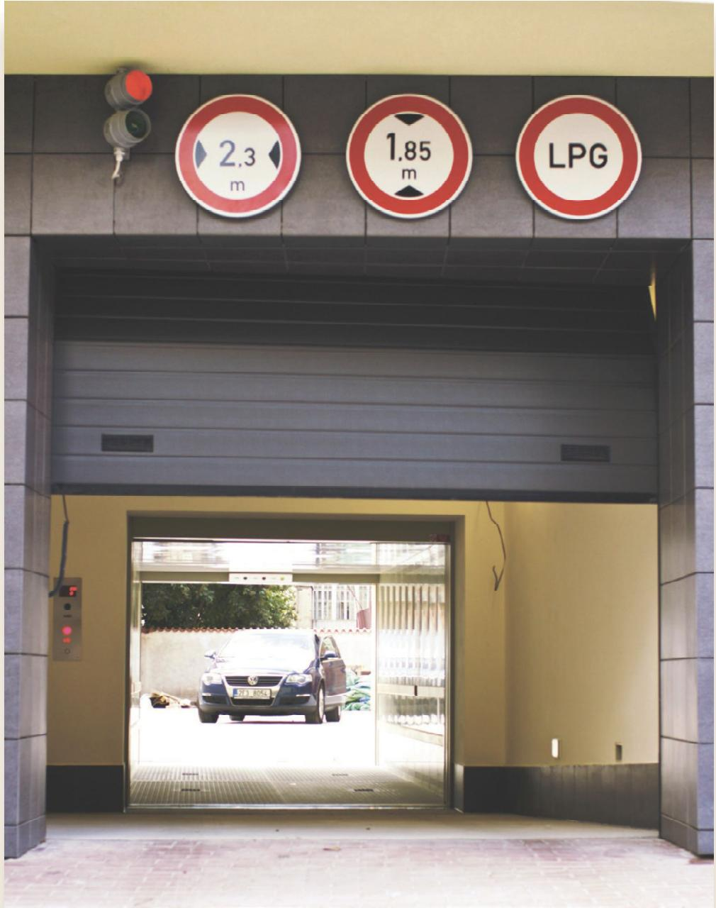
Průjezd výtahem na dvůr budovy řízen světelnou dopravní signalizací
