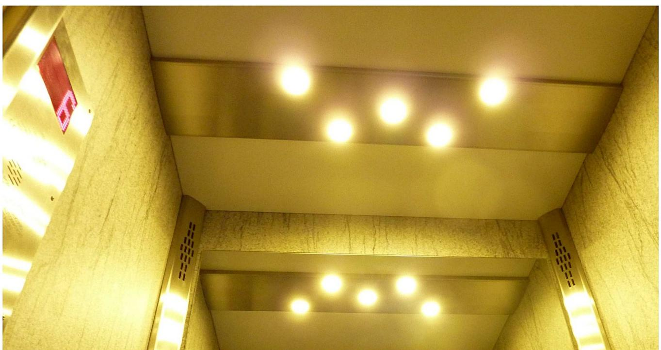
*Nerezový osvětlovací panel s LED reflektory*
